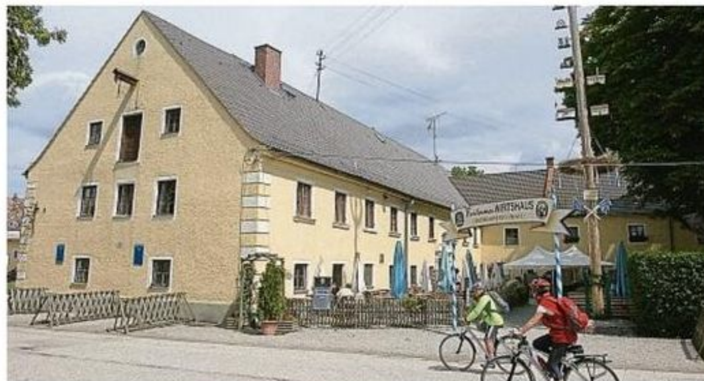
Renovierungsbedürftig: Der Investor will Gaststätte und Biergarten modernisieren.
